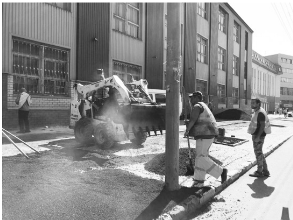
Рис. 4. Ремонтные работы на улице Аткарская (фото А. М. Неврюева)
